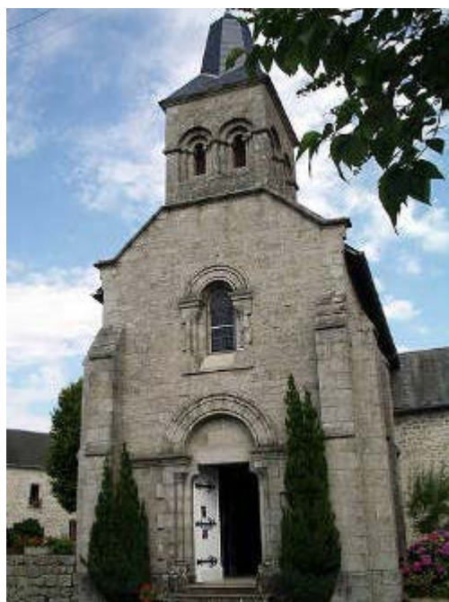
Localisation: Sous-Parsac, Sources image
